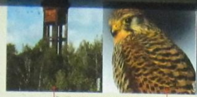
Der Wasserturm ist das Wahrzeichen des Geländes und der Brückpfeiler des Turmsockels.
